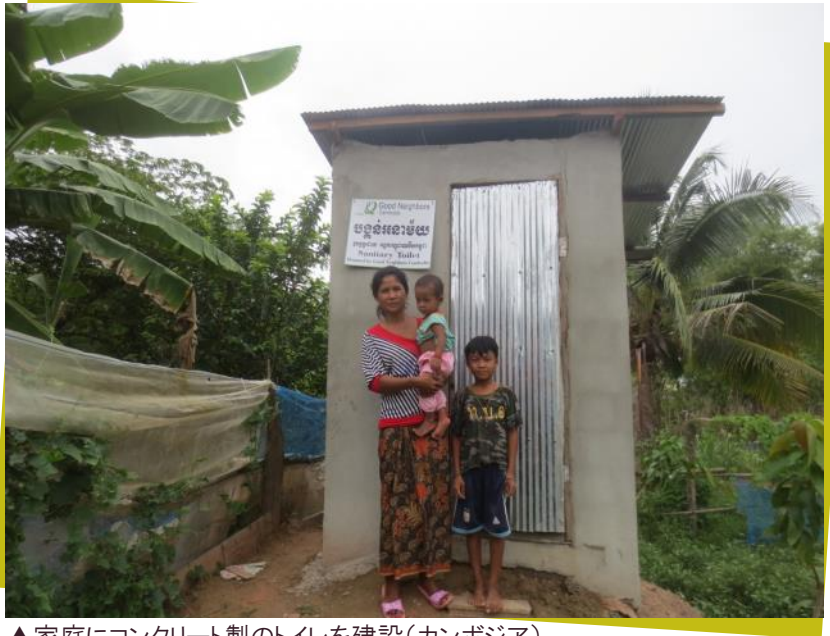
▲家庭にコンクリート製のトイレを建設(カンボジア)
